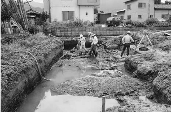
調査風景（西から）
