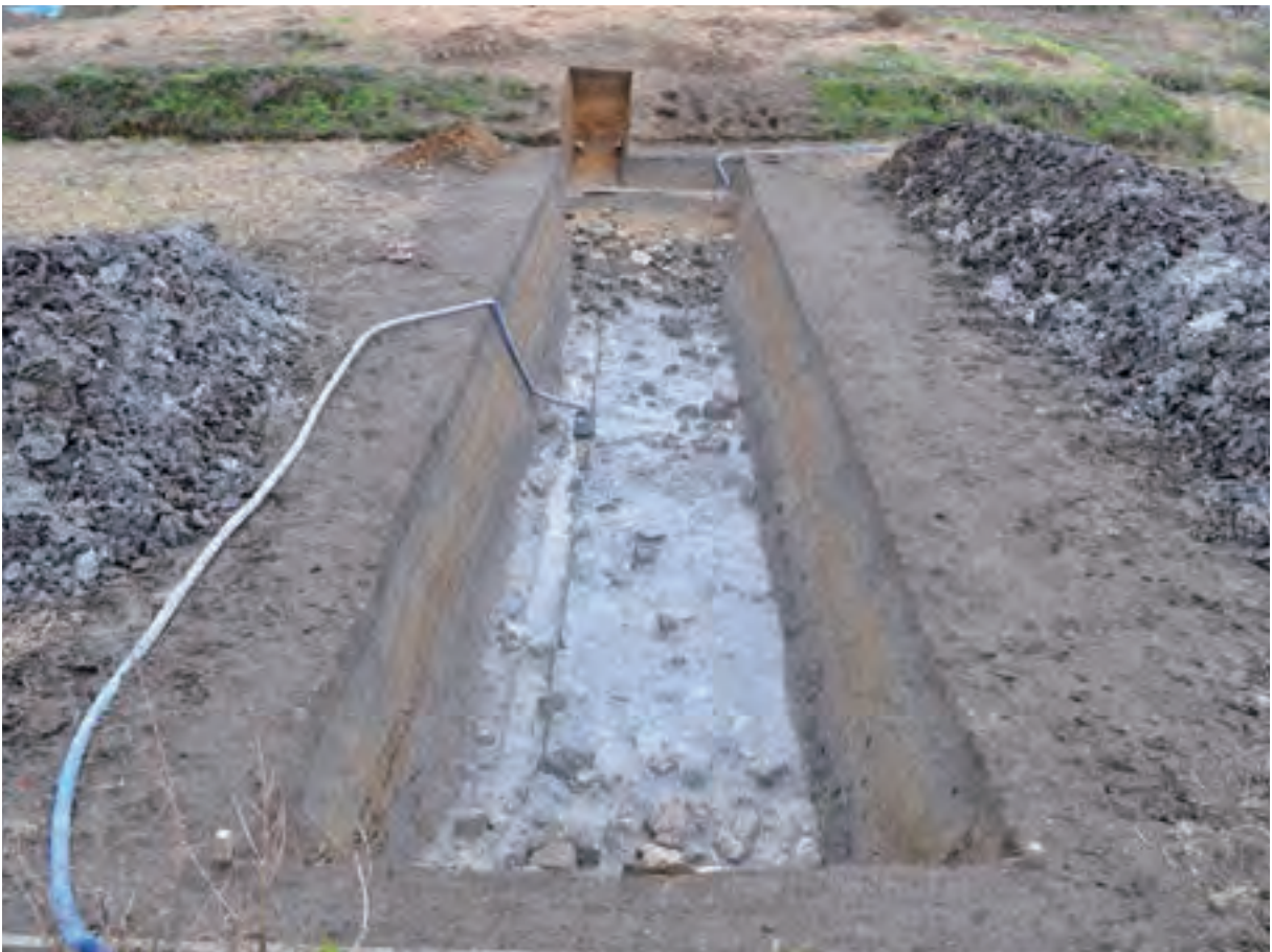
転落石検出状況(北より)
