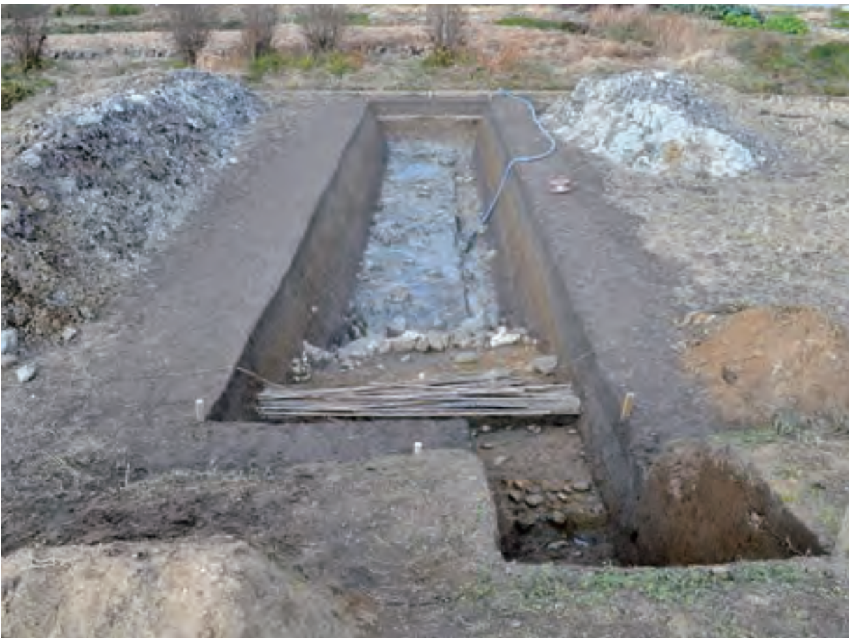
トレンチ全景② (南より)
