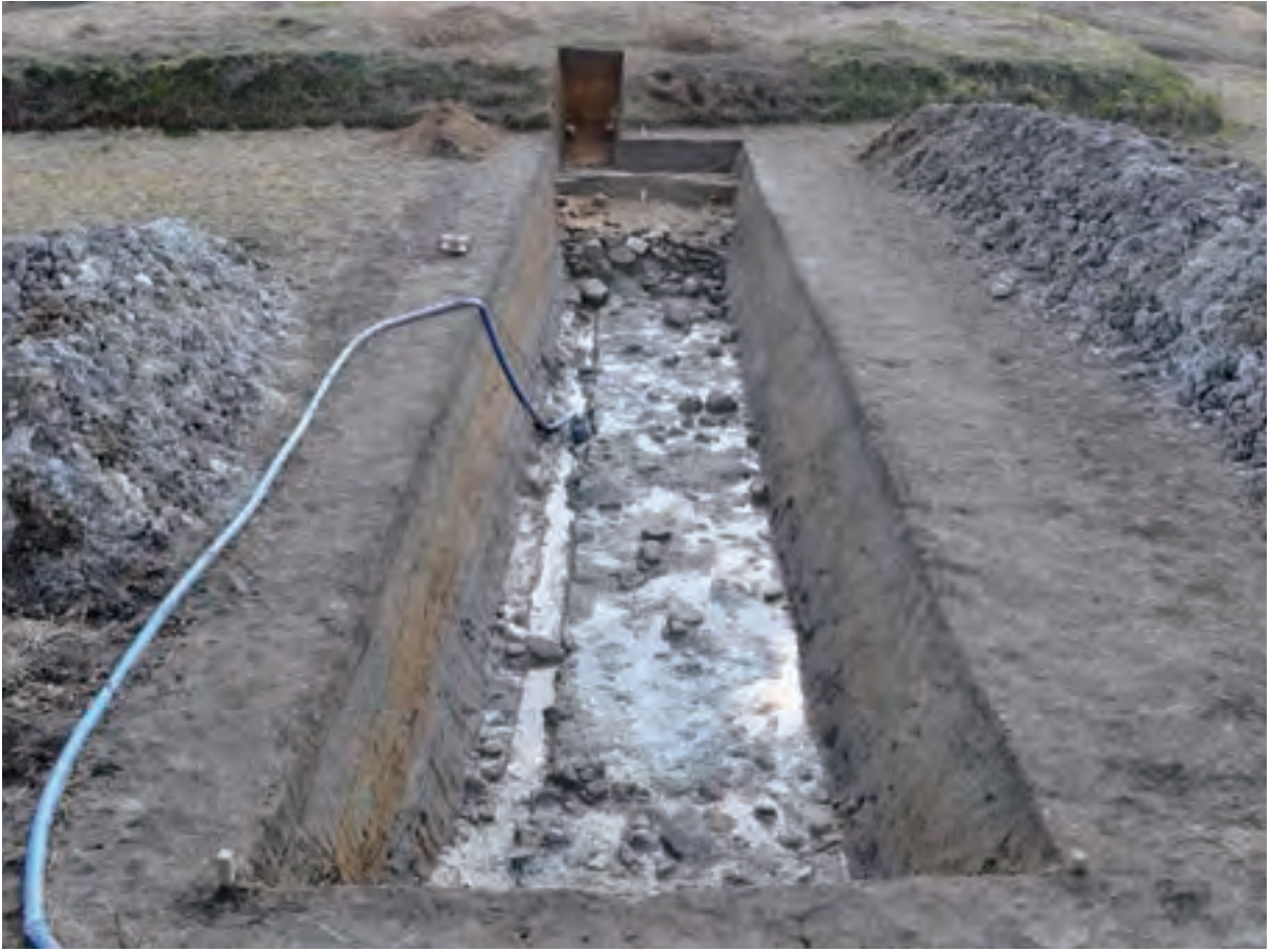
トレンチ全景① (北より)
