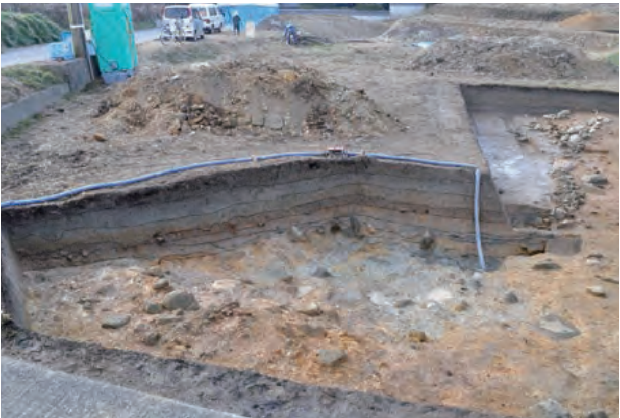
トレンチ北側 周濠埋土完掘状況 (北より)
