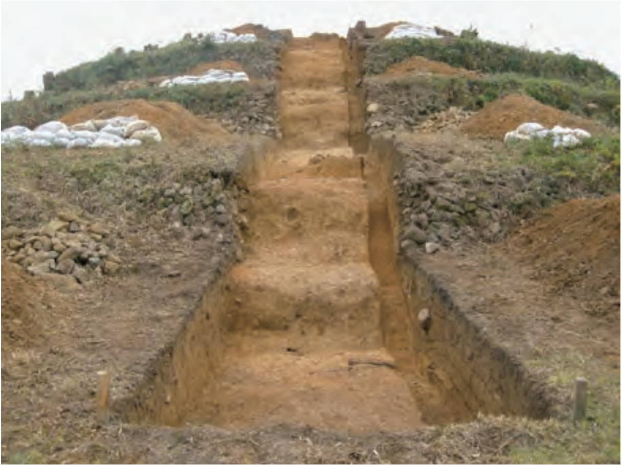
トレンチ全景①(西より)
